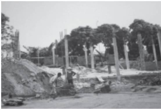
Một kiến trúc nhỏ vừa khởi công tại Chi Dòng Sở Kiện
