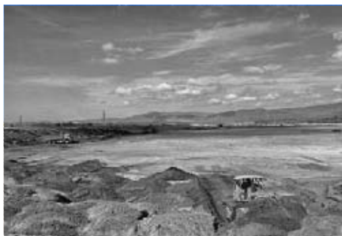
Bãi xỉ than không được xử lý, bốc bụi mỗi khi có gió. RFA
