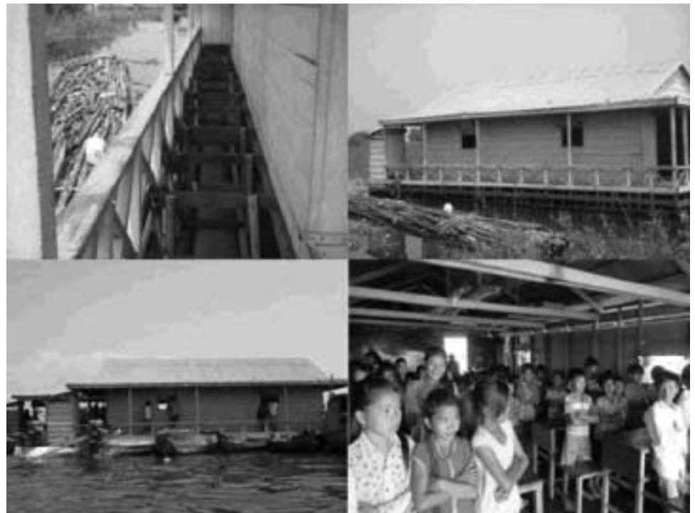
(Hình trên, từ trái: 50 thùng phuy nhựa được dùng thay bè tre để nâng nổi trường. Trường sửa chữa xong, học sinh đã có thể đi học trở lại (hàng ảnh dưới)
