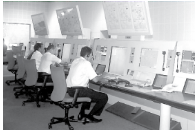
Hệ thống radar ngưng hoạt động ngay sau khi bộ lưu điện bị hỏng
